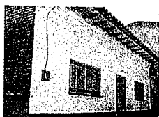
106 de 138 Casa-habitación Inmueble Casa-habitación I-0012004399, Bien Inmueble con Valor Cultural Oaxaca, Santo Domingo Tehuantepec, Santo Domingo Tehuantepec Guadalupe Victoria Siglo XX
