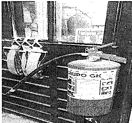
Fig. 4 Segundo extintor contra incendios en el centro de acopio del C. JOSÉ ÁNGEL JUÁREZ GARCÍA
